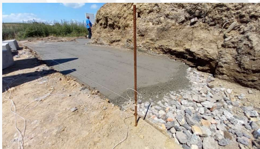
Rys. 3c. Warstwa betonu C12/15
