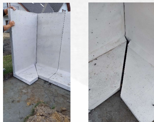
Rys. 5b. Narożniki murów ogrodzeniowych
