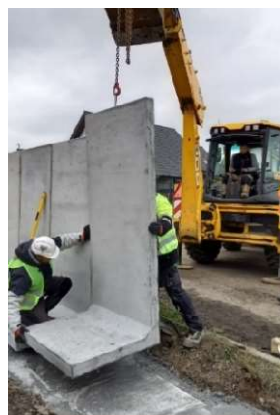
Rys. 1. Początek układania murów ogrodzeniowych na przygotowanym podłożu.
